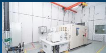
300 KW motor test stand
